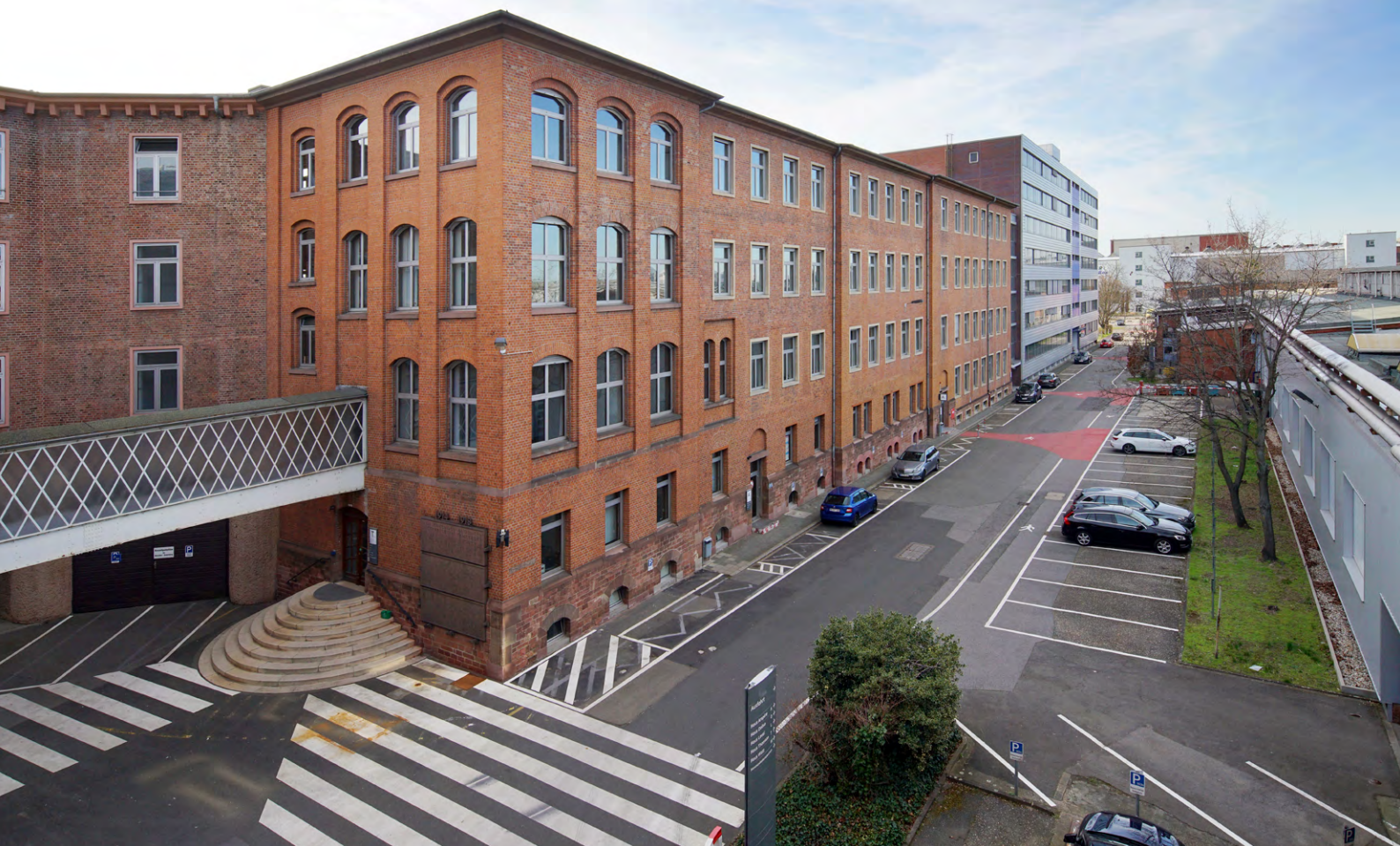
Büroeinheiten eines Gewerbeparks in Mannheim Office units of a business park in Mannheim
