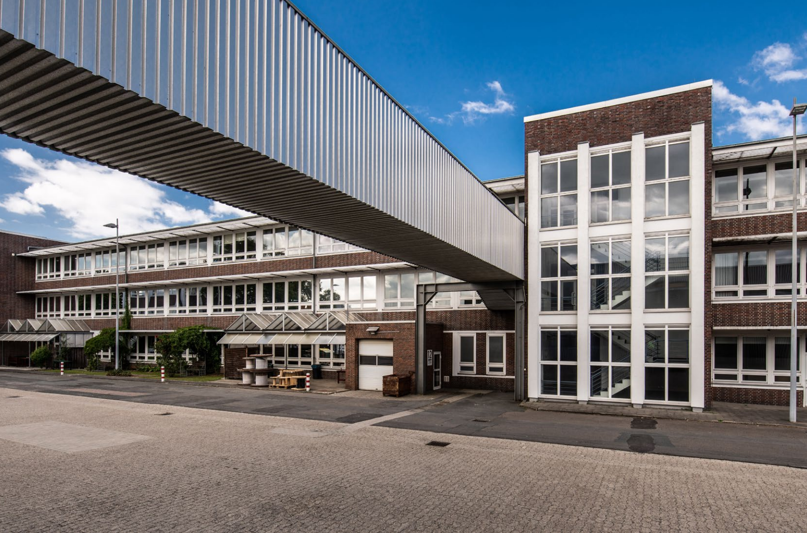
Außenansicht eines Gewerbeparks in Schortens Exterior View of a business park in Schortens
