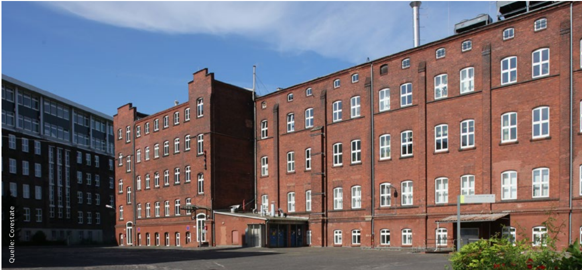
Außenansicht des Berlinbiotechpark Exterior view of the berlinbiotechpark
