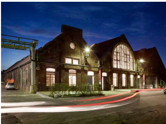
Carlswerk in Köln
